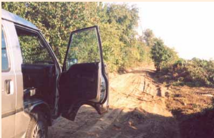
Droga gruntowa w Słajkowie podczas remontu – 2002
