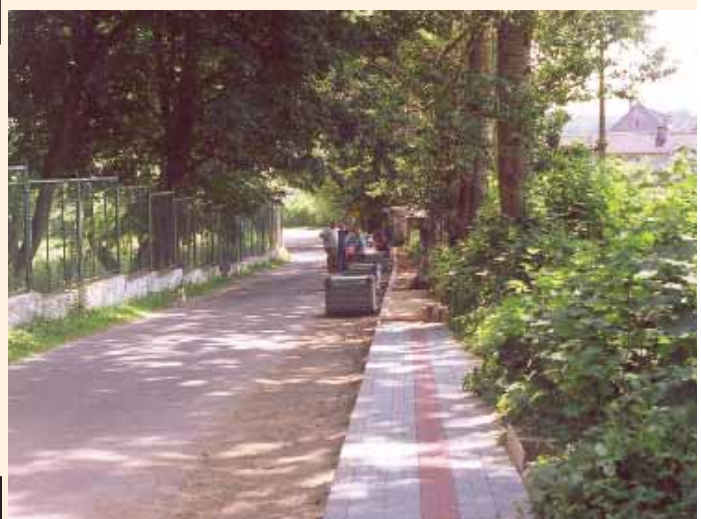
Budowa chodnika w Zwartowie – 2006
