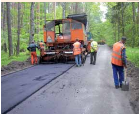
Budowa drogi Żelazno-Zwartowo – 2008
