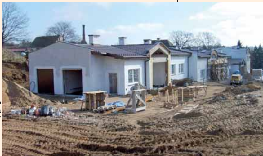
Budowa Gminnego Ośrodka Zdrowia w Choczewie - 2007
