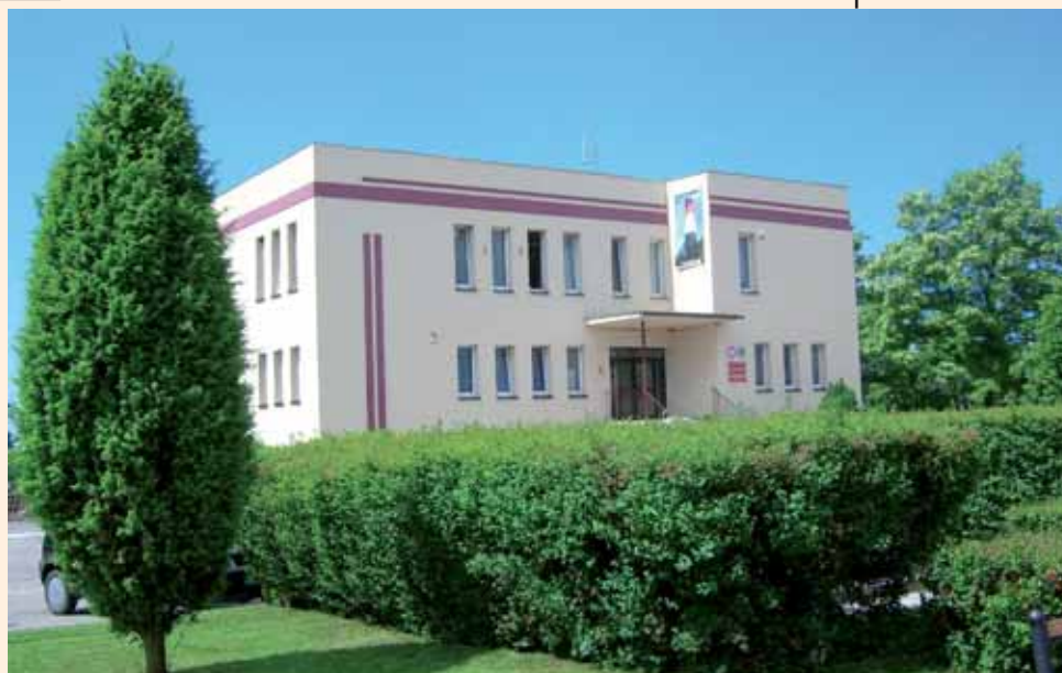
....i po termomodernizacji – 2006
