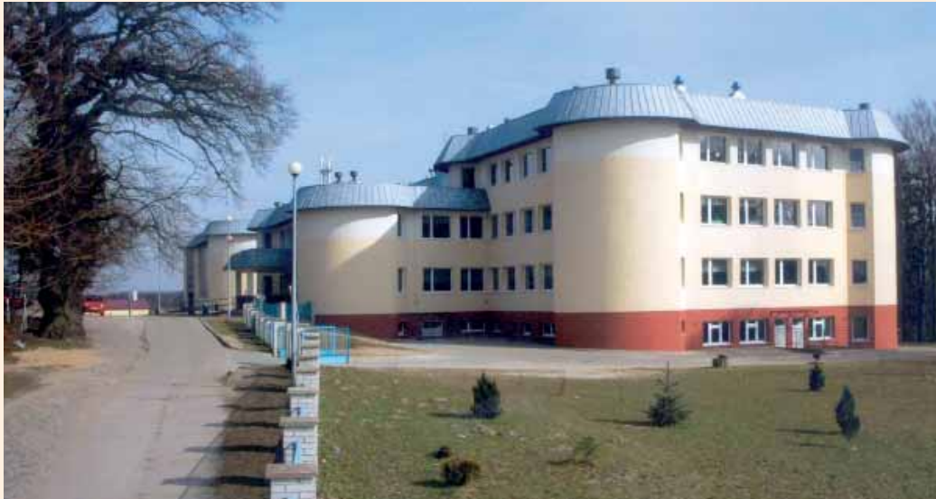
... i po termomodernizacji – 2004
