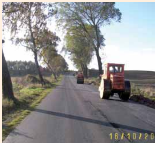
Remont drogi do Kierzkowa – 2009
