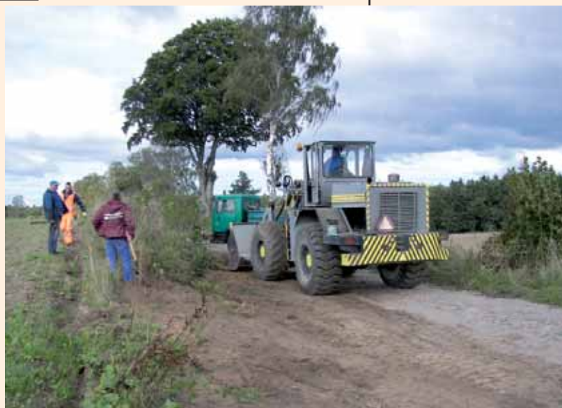
Remont drogi do Zwarcienka – 2008
