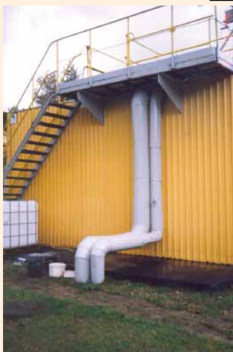
Bioblok oczyszczalni w Choczewie po remoncie – 2003
