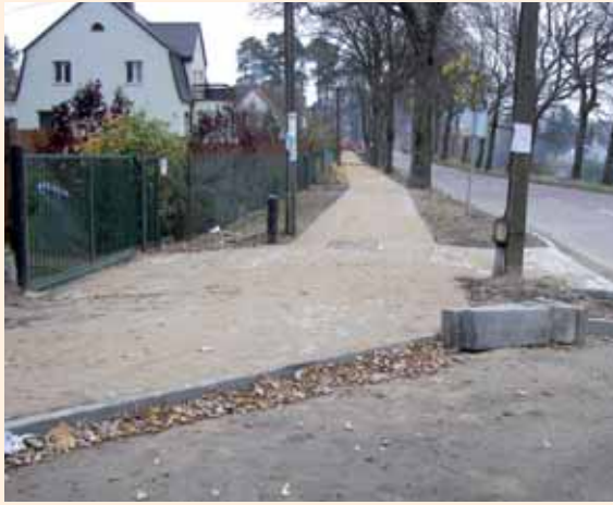
Budowa chodnika ul. Pierwszych Osadników w Choczewie – 2009
