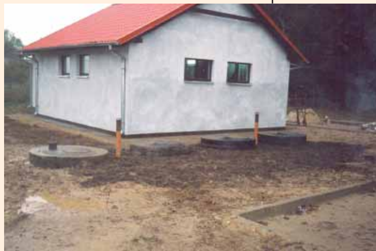
Budowa hydrofornii w Kopalinie
