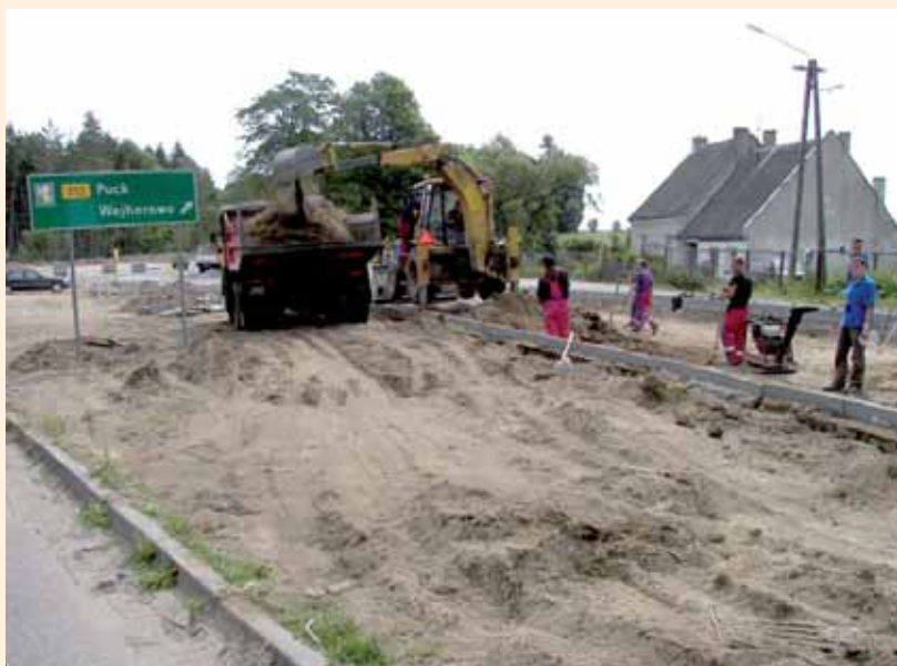
Budowa ronda w Żelaznej – 2007
