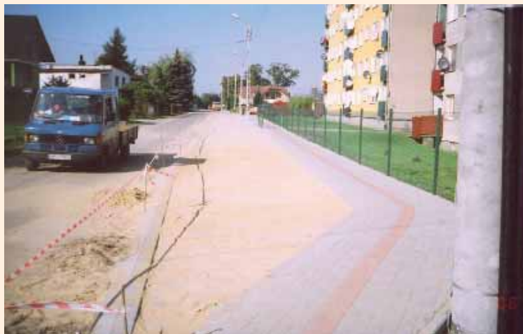
Budowa chodnika i parkingu przy ul. Wojska Polskiego w Choczewie – 2006
