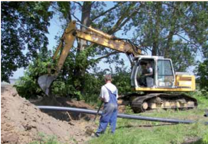
Budowa sieci kanalizacyjnej Lublewo-Lublewko-Choczewo – 2006
