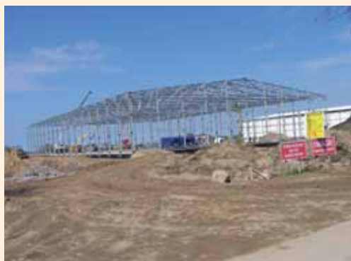
Budowa hali do przetwórstwa rolno-spożywczego – 2010
