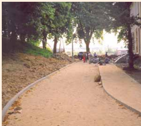
Układanie kostki brukowej wokół tzw. starej szkoły - 2005
