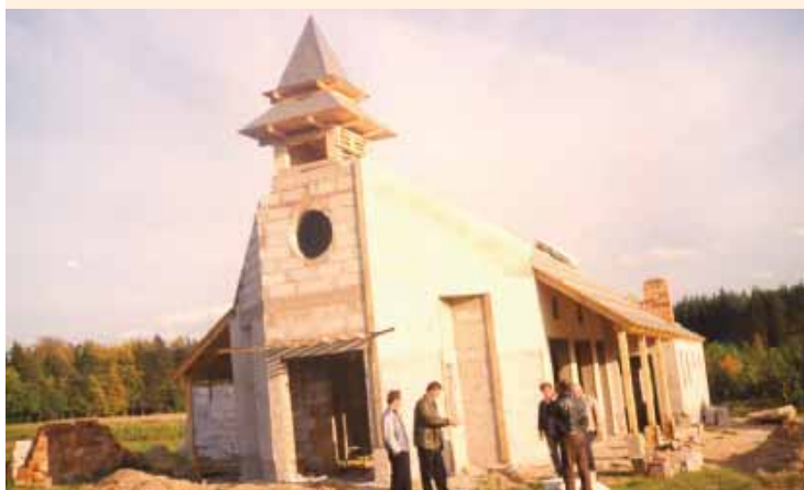
Budowa Domu Przedpogrzebowego – 1993
