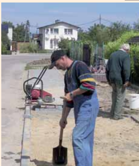
Budowa chodnika w Stąszewie – 2006
