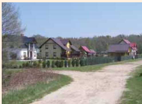
Budownictwo mieszkaniowo-rekreacyjne w Lubiatowie – 2010
