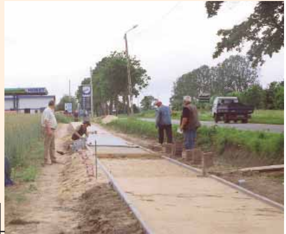
Budowa chodnika ul. Pucka w Choczewie – 2006
