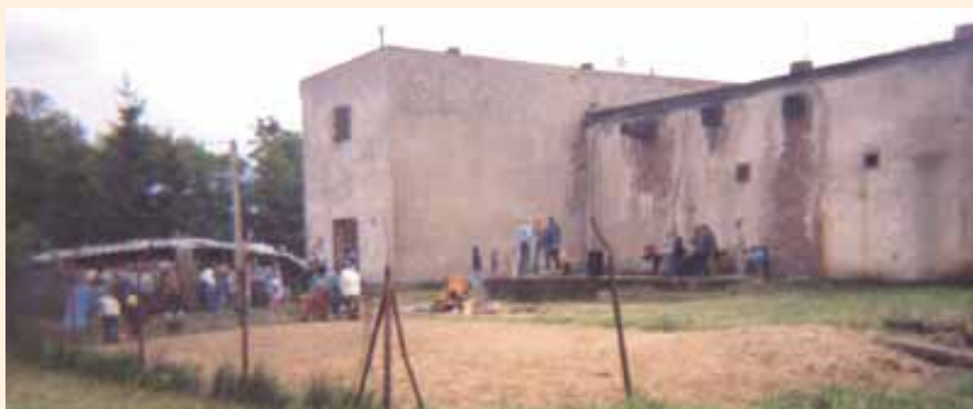
Obiekt ogólnodostępny w Żelaznej podczas remontu ...
