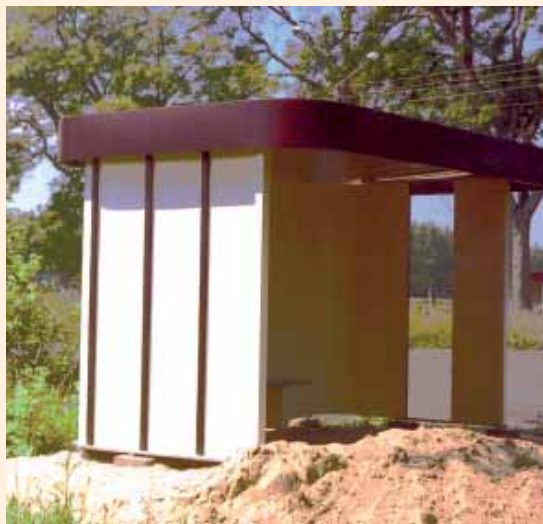
Budowa przystanku w Borkowie – 2006
