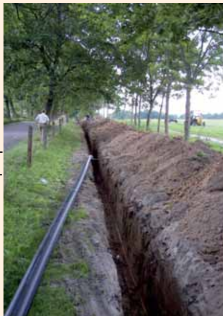
Budowa kanalizacji Zwartowo-Żelazno – 2009
