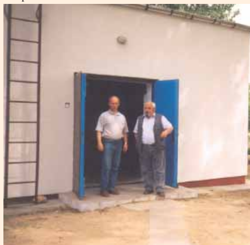
...i po remoncie
