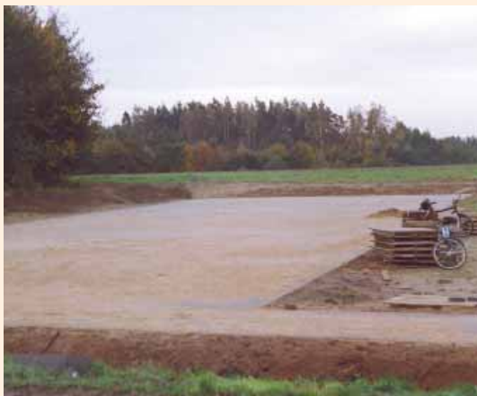
Parking przy cmentarzu w Choczewie – 2006
