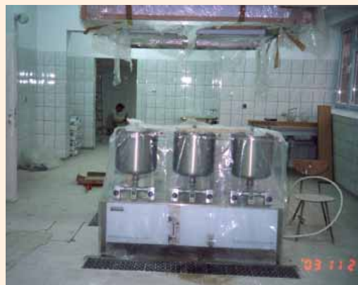
Kuchnia Zespołu Szkół w Choczewie podczas modernizacji
