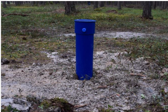
Przykładowy piezometr znajdujący się w gminie Choczewo wykorzystywany do pomiarów poziomu swobodnego zwierciadła wody w warstwach wodonośnych
