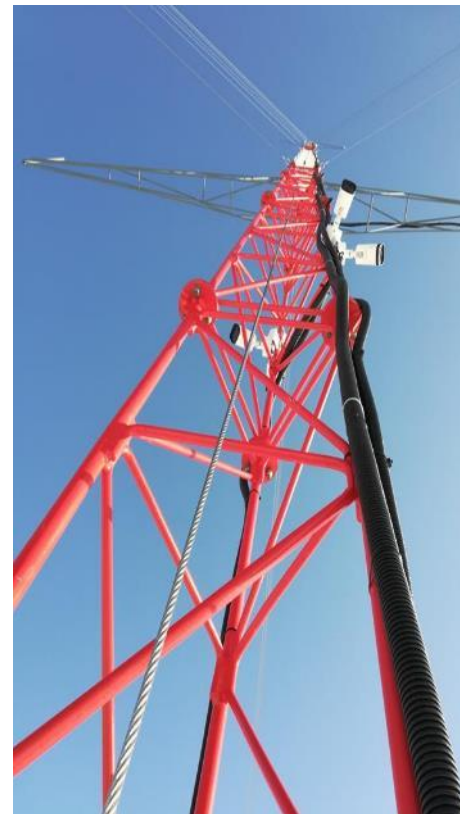
Maszt pomiarowy w Lubiatowie
